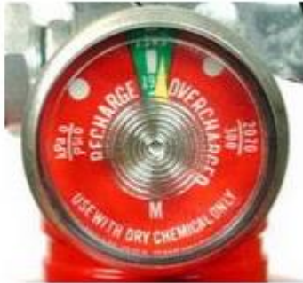
ภาพ Pressure Gauge ของถังดับเพลิง พร้อมใช้งาน (เข็มสีเขียวอยู่ในพื้นที่สีเขียว)
